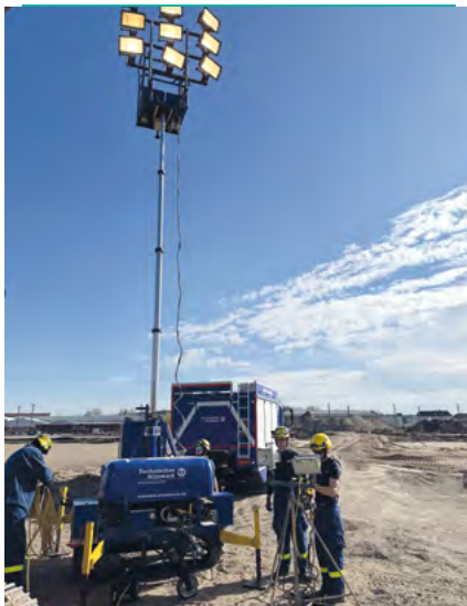
Aufbau einer Scheinwerferanlage zur Ausleuchtung im Rahmen einer Bombenräumung im Lok-Viertel
